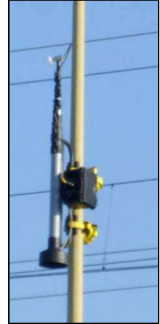
fig. 11 unità di rilevamento posizionata in quota
